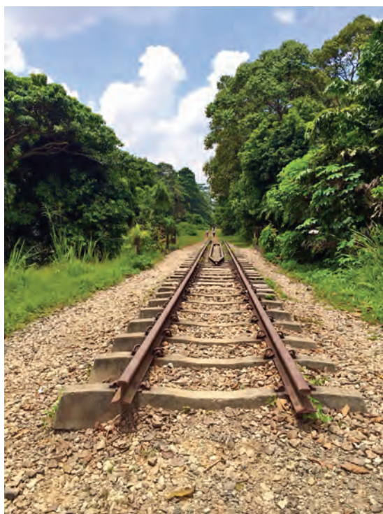
旧铁路 陈永嫻 (新加坡聚英中学)
